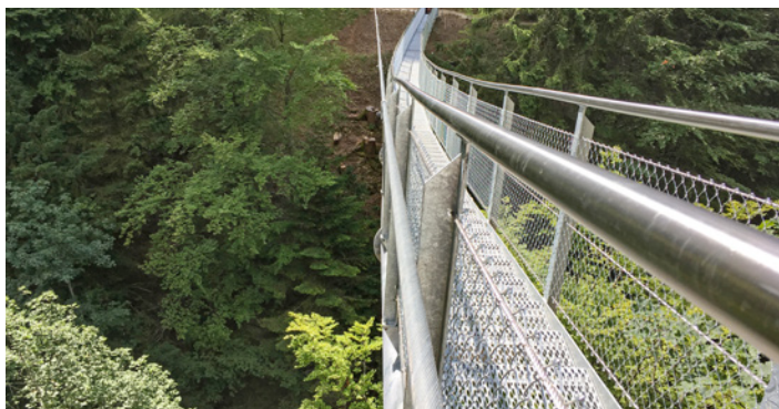
Das Besondere an der Sundbachbrücke ist der auf halber Brückenlänge angelegte Übergang von einer Brücke zu einer Treppe.
