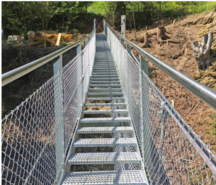
Für den 80 cm breiten Laufsteg kamen Blechprofilroste Typ Serrated zur Anwendung.
